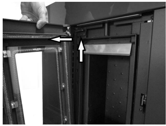
Fig. 21 - Odstranitev vrat
