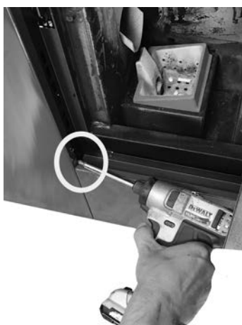
Fig. 44 - Odstranjanje vijakov 1
