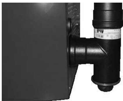
Fig. 63 - Čiščenje dimnega kanala
